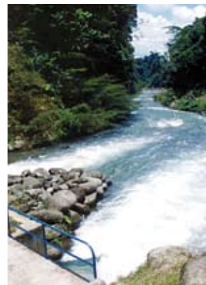
Windparks und Wasserkraftwerke privater Investoren finanziert die DEG unter anderem in China, Indien, der Türkei, Brasilien und Peru mit. Geothermie kann in Ländern wie Kenia oder Indonesien genutzt werden, um die Stromversorgung klimaneutral zu verbessern.
